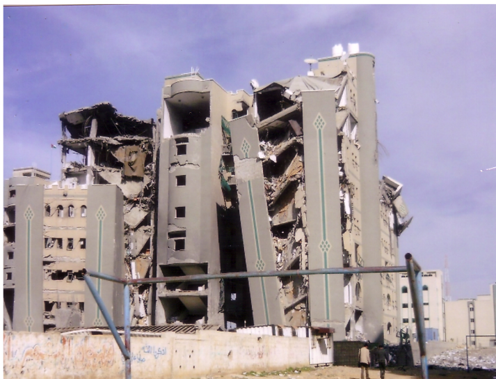
病院も破壊された
