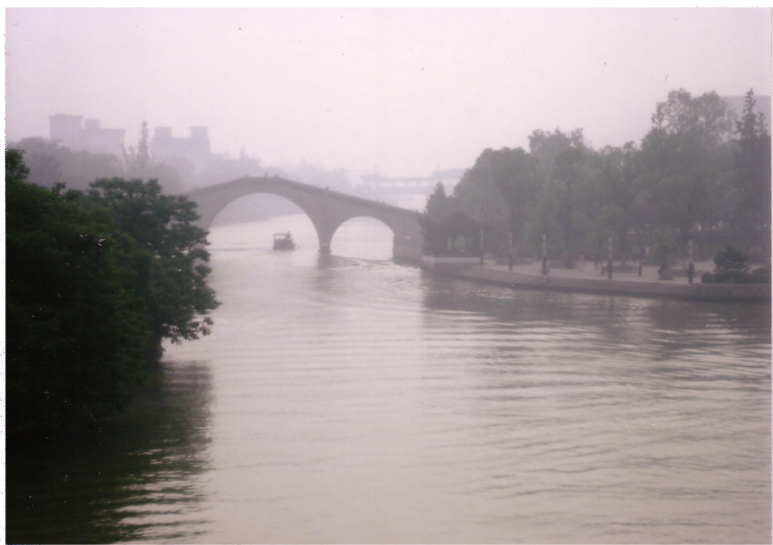
屋の京杭大運河
