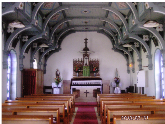
教会建築史上でも珍しい折り上げ式天井
