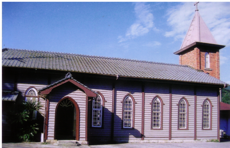
明治36年に建てられた旧聖堂
