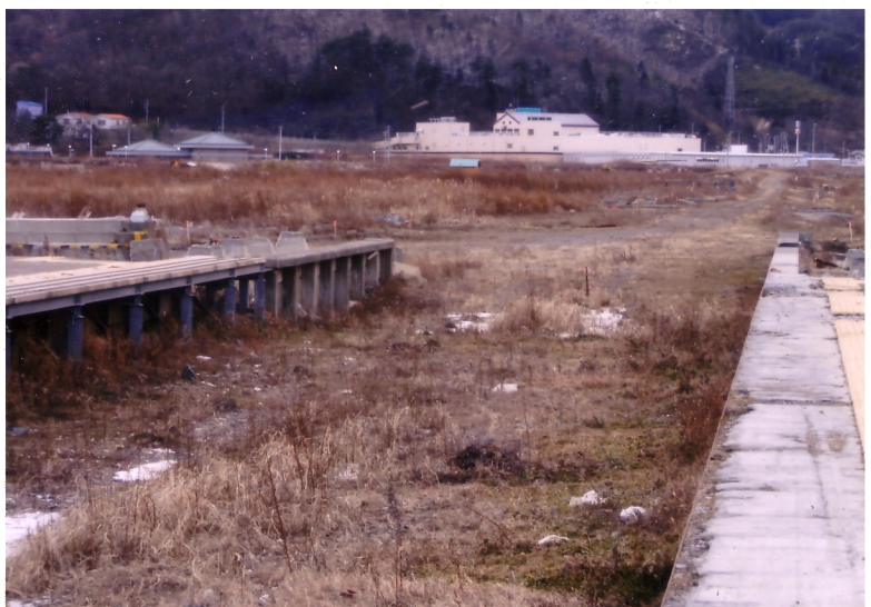
大槌駅はプラットホームだけが残された
