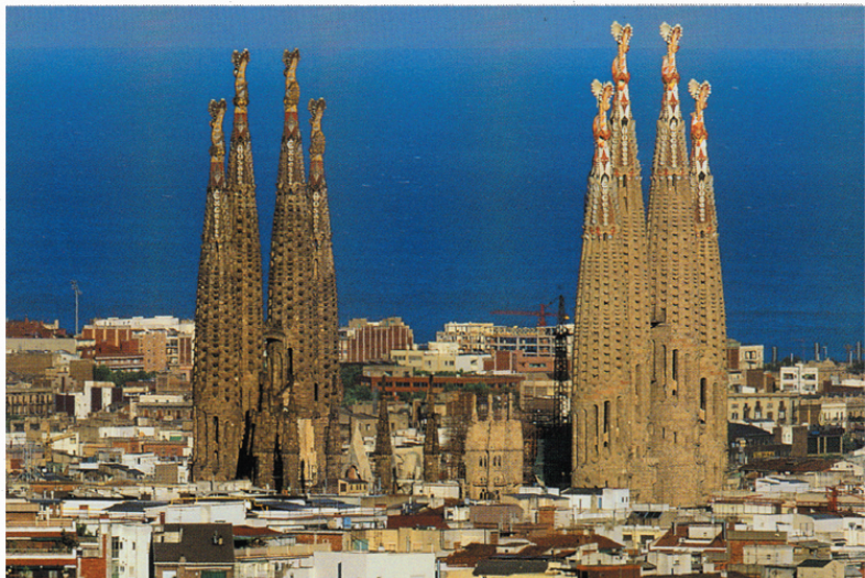
12本のうち8本が完成した鐘塔
