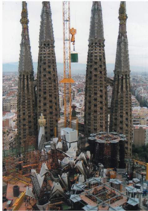
残る鐘塔4本の建設現場
