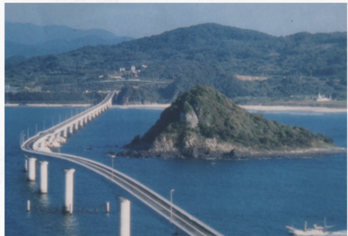
小島を迂回して建設された大橋
